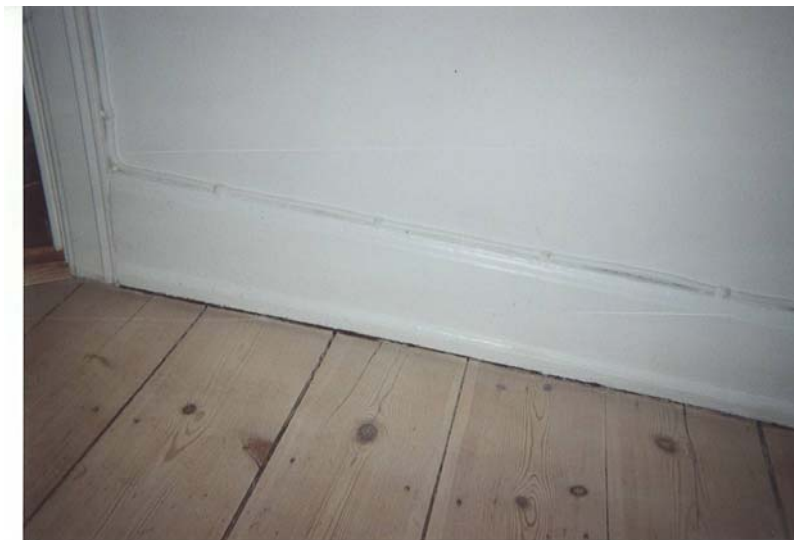
Detalje vedrørende føring af supplerende el
