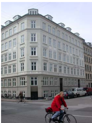
Facade mod Istedgade/Eskildsgade efter byggesagens afslutning (april 2006)
