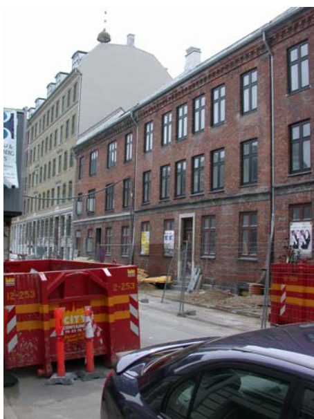
Byfornyelsesarbejderne nærmer sig deres afslutning (april 2006)
