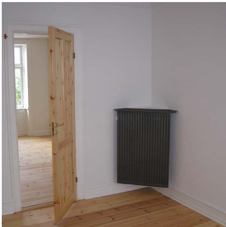
Fig 1 Radiator i værelse mod gade i Eskildsgade.
